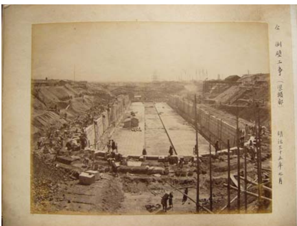
図-1 函館どつくの施工状況
